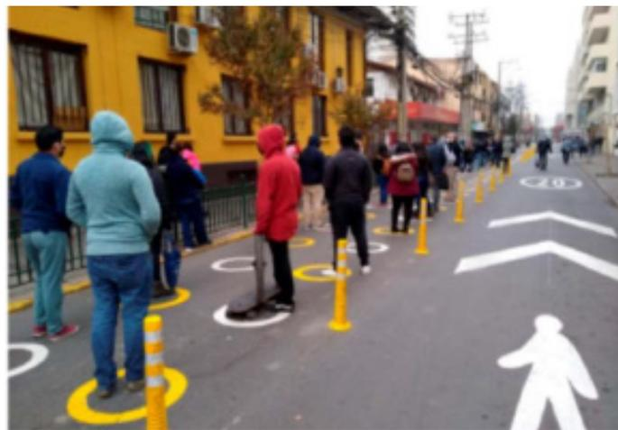
La utilización de pintura en la calzada y el uso de elementos móviles de segregación ayuda a distinguir el nuevo uso operacional de la vía sin invertir en obras físicas. Imagen superior, delimitación de sectores de espera en Rancagua.
