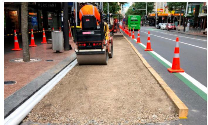
En caso de transformarse en una solución permanente, se recomienda nivelar toda la vía a nivel de acera. En la imagen, intervención de Auckland, Nueva Zelanda, permitió ganar espacio en una vereda ajustada de un sector de alto nivel de uso.
